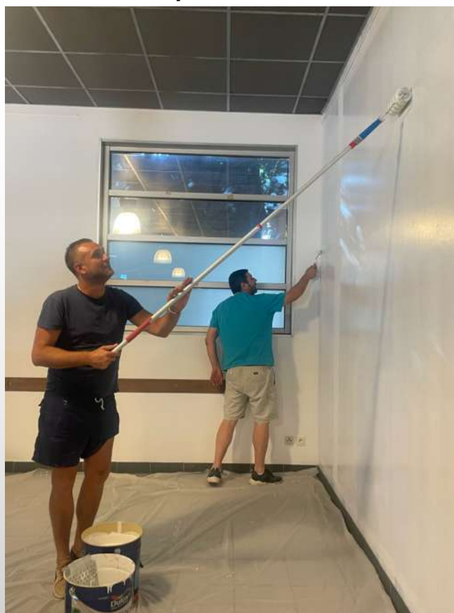
Remise au propre de la salle polyvalente de Pont-de-Crau
